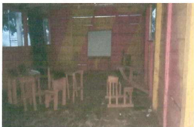
Foto 3: mejoramiento de piso losa
