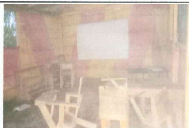
Foto 4: mejoramiento de muro
