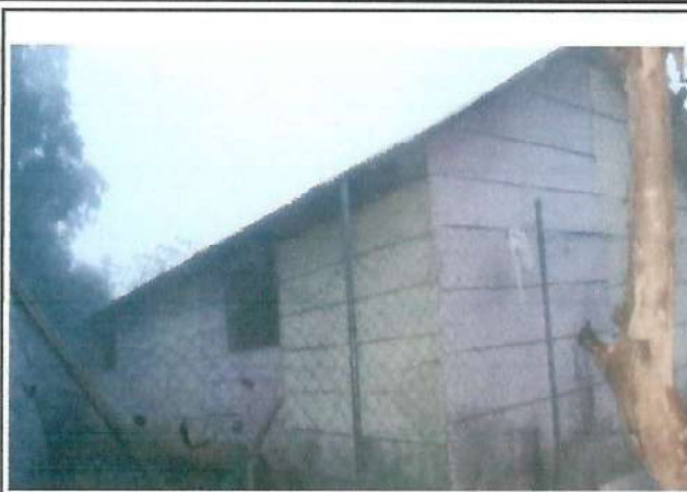
Foto 2: mejoramiento de entechado de lámina troquelada calibre 26
