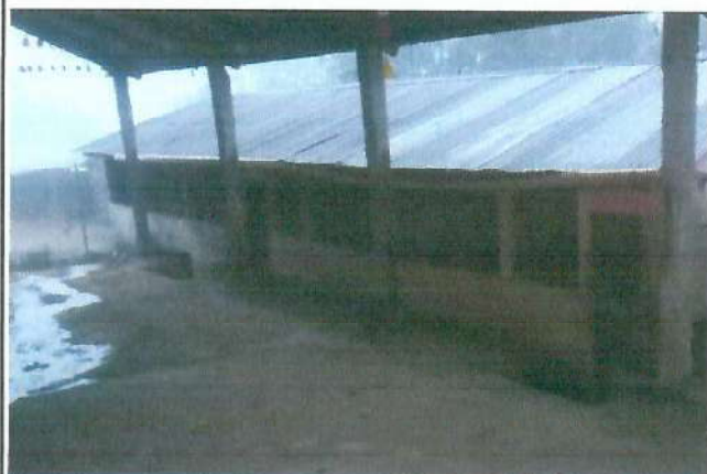
Foto1: mejoramiento de ventilación
